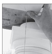
5. Aplome la columna. Asegúrese que la carga esté distribuida y centrada uniformemente alrededor de la superficie portante.
