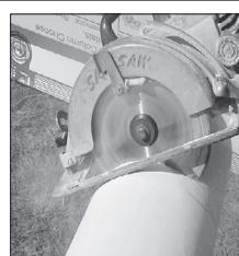
2. Use una sierra abrasiva (para mampostería o hoja de Carburo) para emparejar la parte superior e inferior y asegurar un buen contacto con la superficie.
