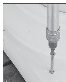
8. Aplique el pegamento a la parte inferior de la Base. Asegure con tornillos o clavos.
