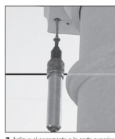
7. Aplique el pegamento a la parte superior del Capital presionando hacia arriba. Asegure con tornillos o clavos.
